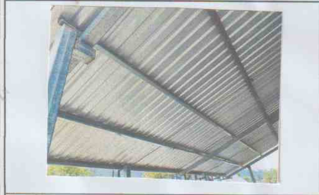
Foto 1: Estructura de techo
