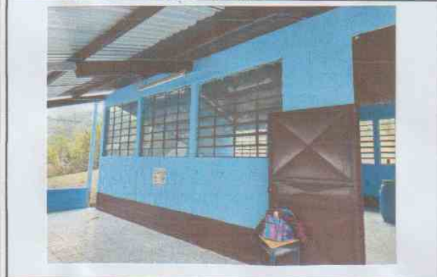
Foto 3: Pintura en muro interior y exterior
