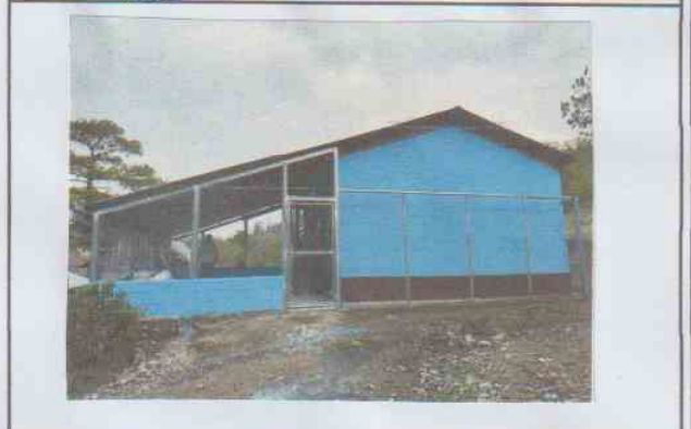
Foto 4: Cercos o muro perimetral
